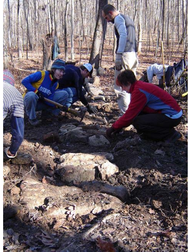
(d) Anchor stones are laid.
